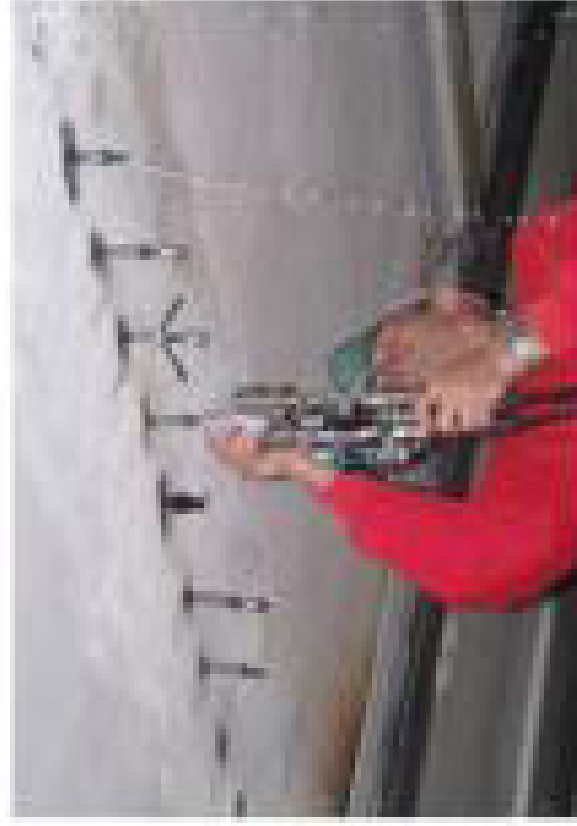
Водяна, горизонтальна гідроізоляція
