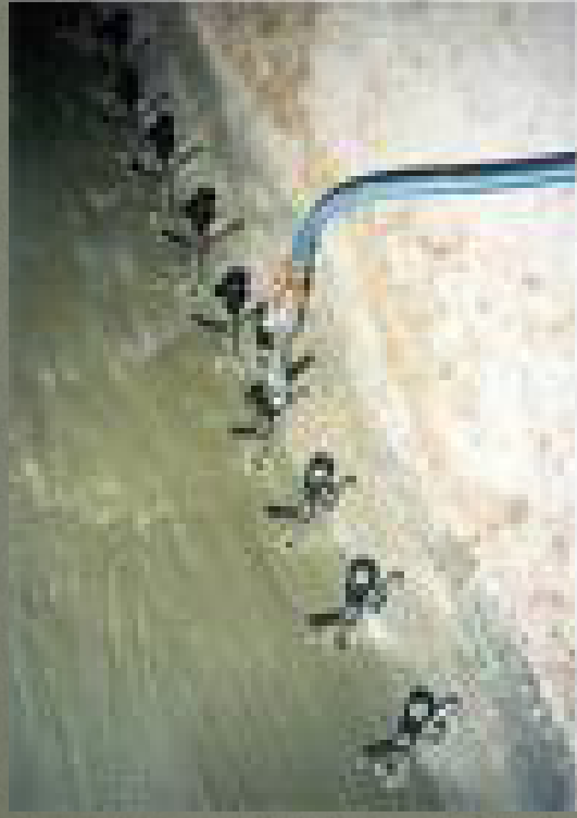
Водяна, горизонтальна гідроізоляція
